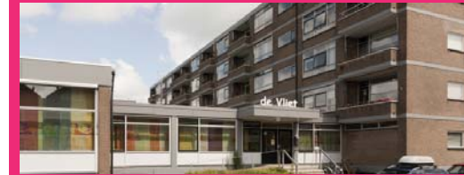
OC De Vliet, Maassluis
